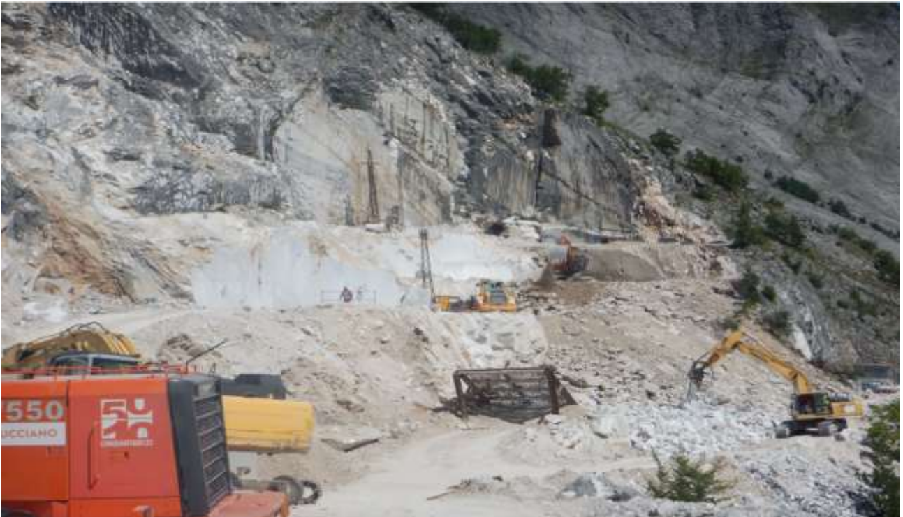
Foto 1: Panoramica della cava Bacolaio di Cima, al centro e sulla destra mezzi cingolati al lavoro che effettuavano movimento terra e spaccavano detriti producendo abbondanti polveri su strade e piazzali.
