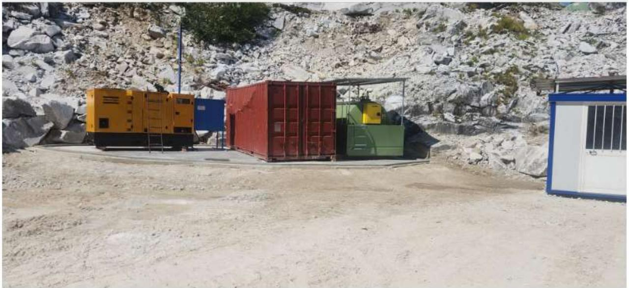
**Foto 1:** Area servizi dove è stata realizzata una gettata in calcestruzzo non strutturale su cui sono alloggiati cisterna carburanti, generatore e container;
