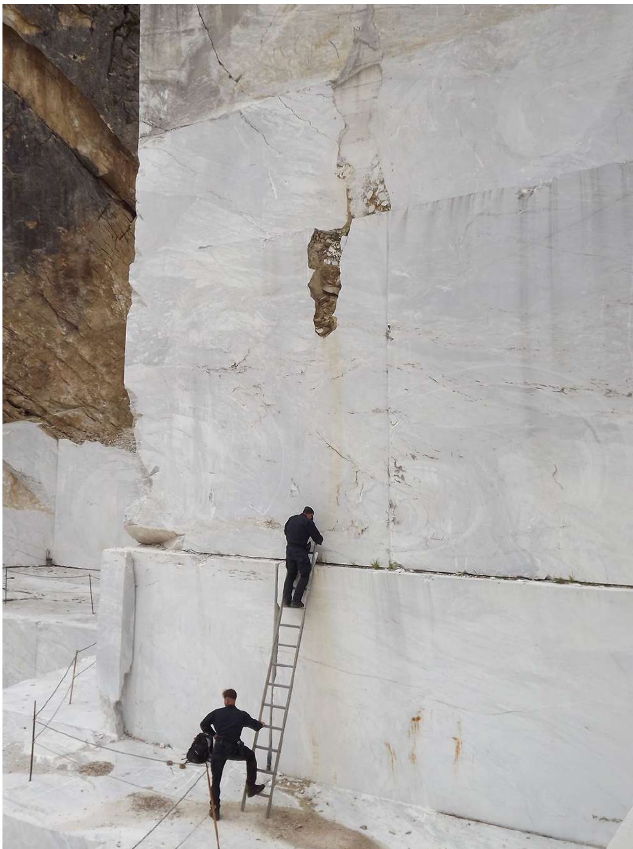
La parte bassa della cavità carsica dopo le opere di tombatura con calcestruzzo
