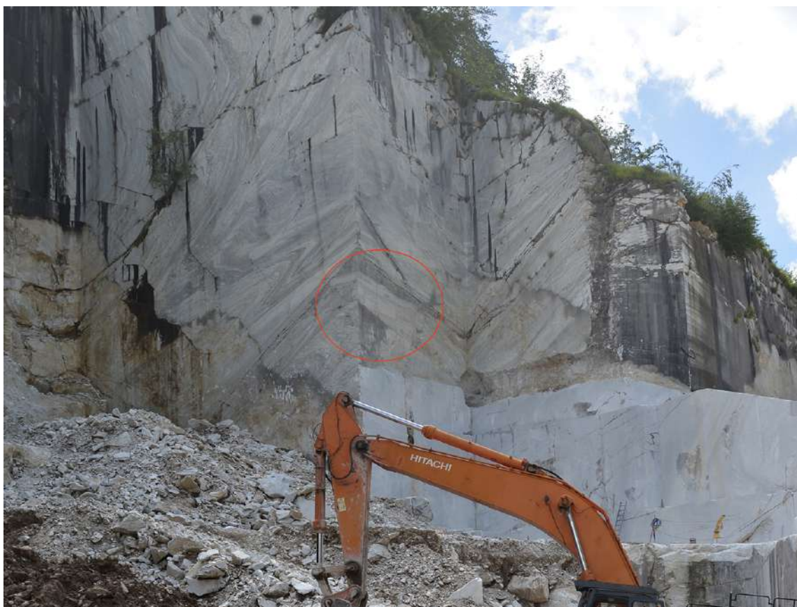
L'ingresso della cavità carsica dopo le opere di tombatura con calcestruzzo
