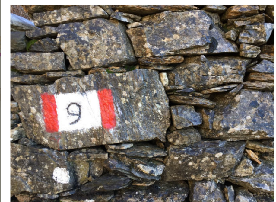
particolare muratura foto d
