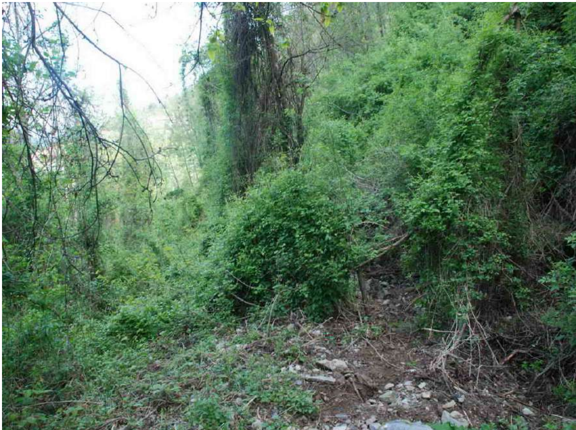
Foto 1 – Lo stato attuale del Sentiero 38 completamente alterato dall'assenza di regimazione delle acque
