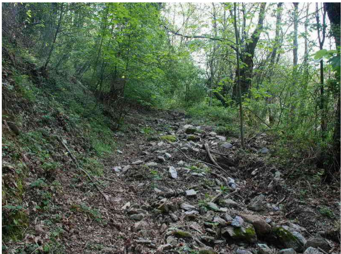
Foto 2 - Lo stato attuale Sentiero 38 con gli attraversamenti completamente intasati dal materiale franato
