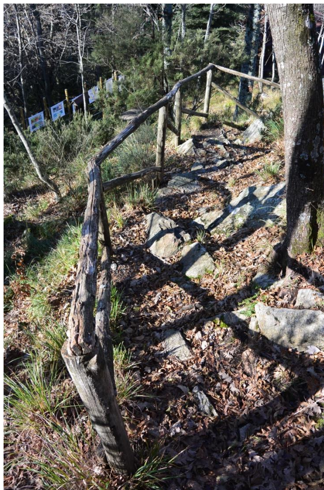
Foto 10-11. Tratti di staccionata deteriorata in prossimità del rifugio-laboratorio e nel tratto finale dell'itinerario di visita
