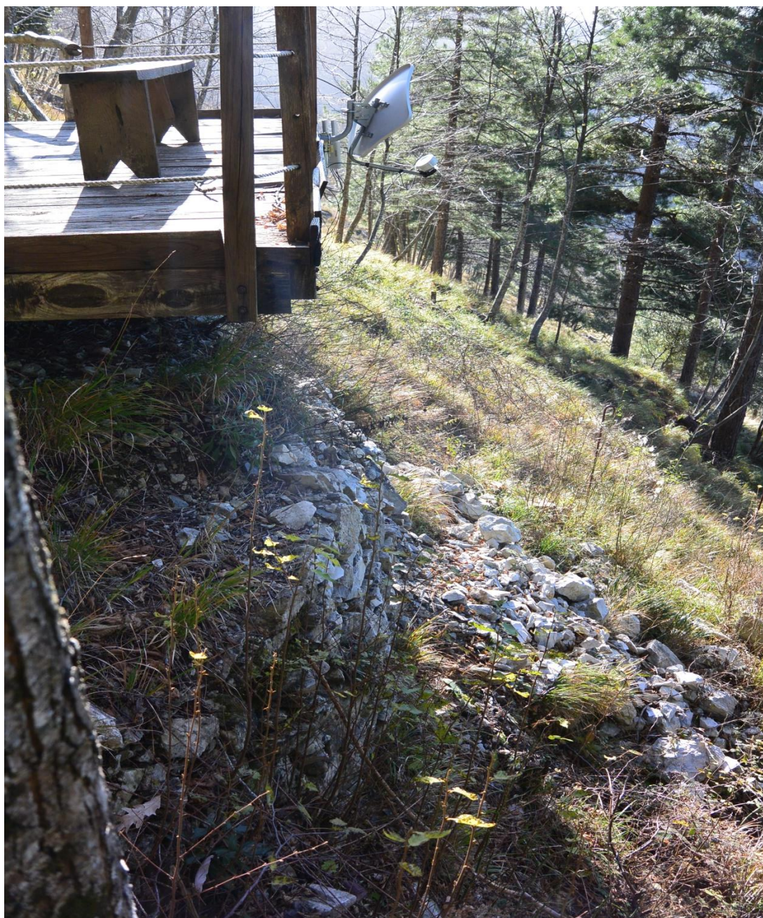
Foto 12. Tratto di muretto a secco franato in prossimità della piazzola panoramica lungo il percorso ad accesso facilitato
