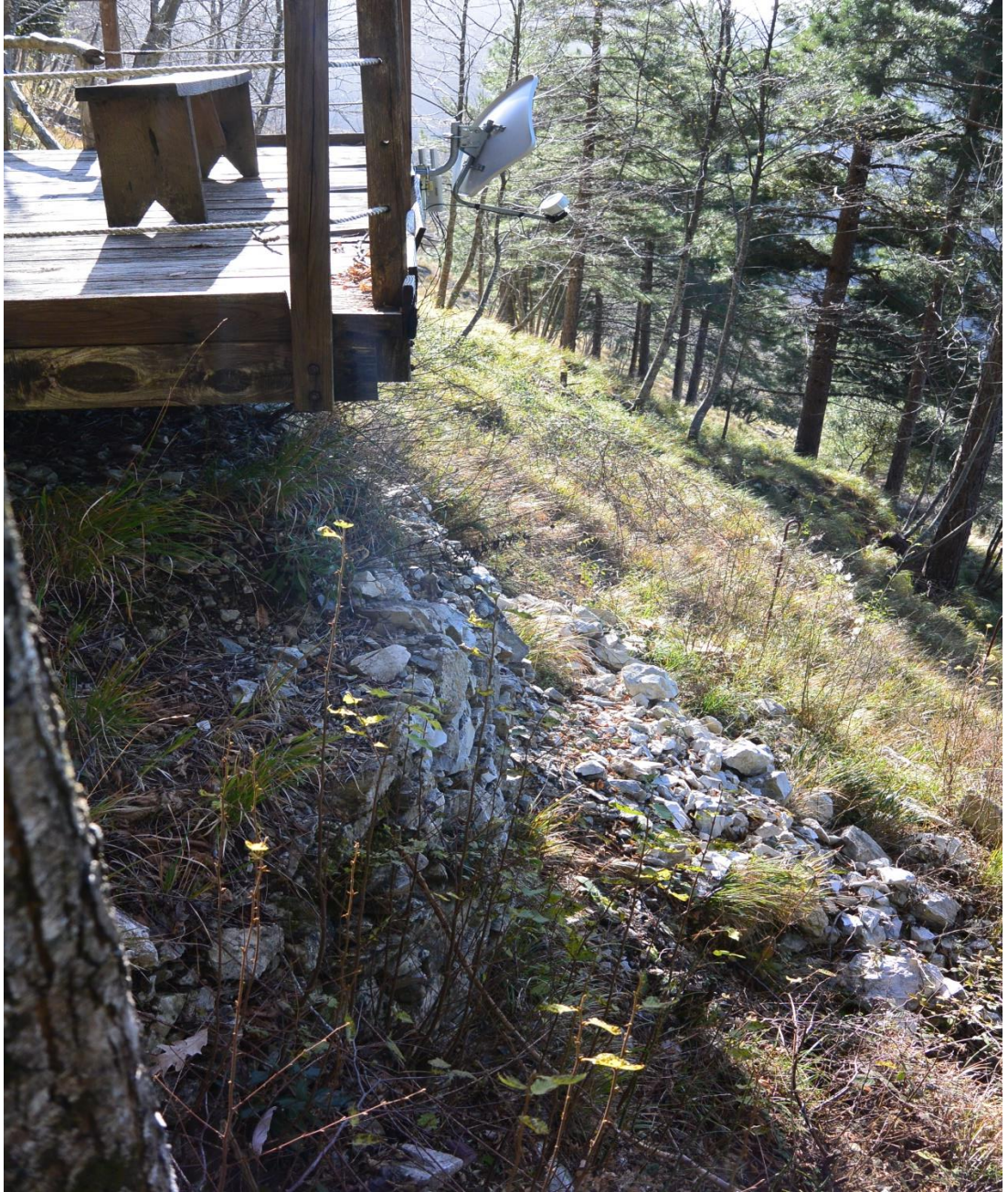
Foto 12. Tratto di muretto a secco franato in prossimità della piazzola panoramica lungo il percorso ad accesso facilitato
