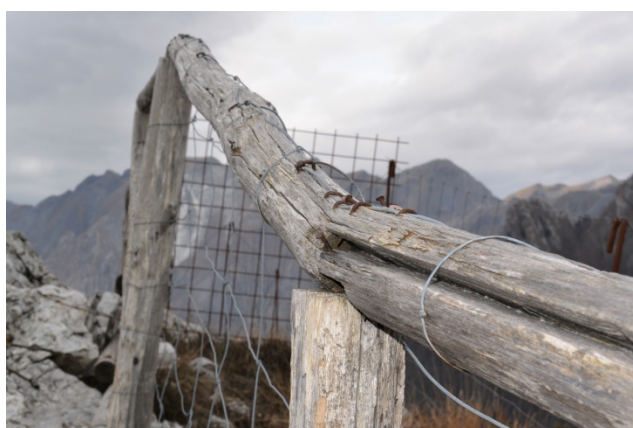
Foto 10. Tratto di staccionata degradato in vetta
