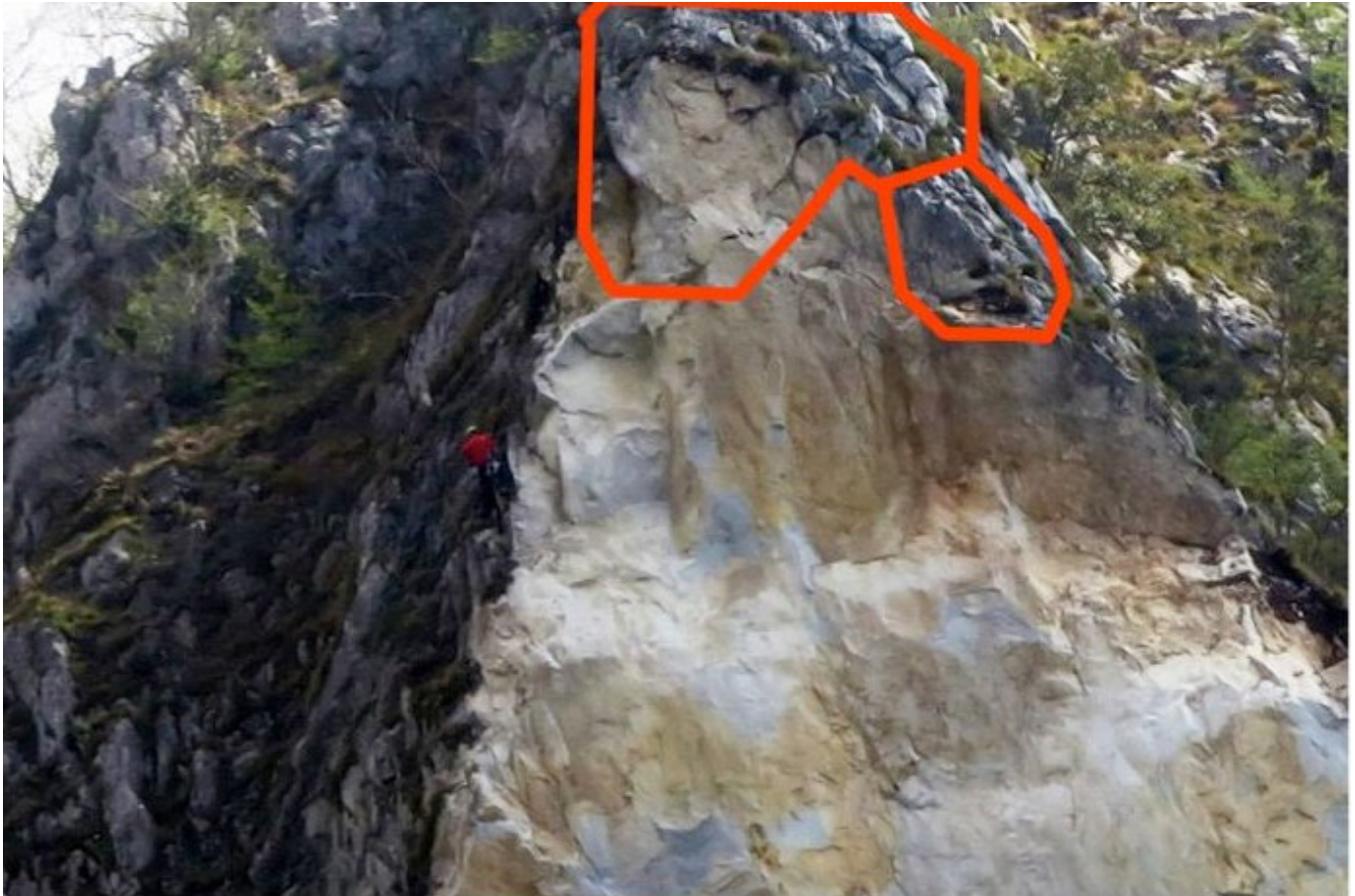
Figura 7 – Evidenziazione della zona più instabile e oggetto dell'opera di disaggio
