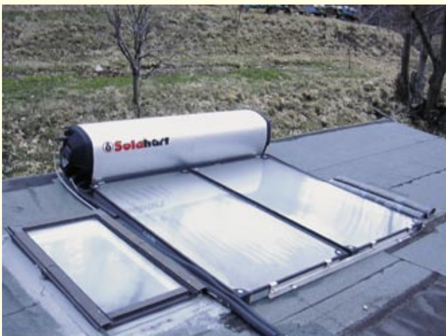
Pannello solare fotovoltaico installato sulle strutture dell'Associazione Il Sentiero (foto M. Tavoni)
